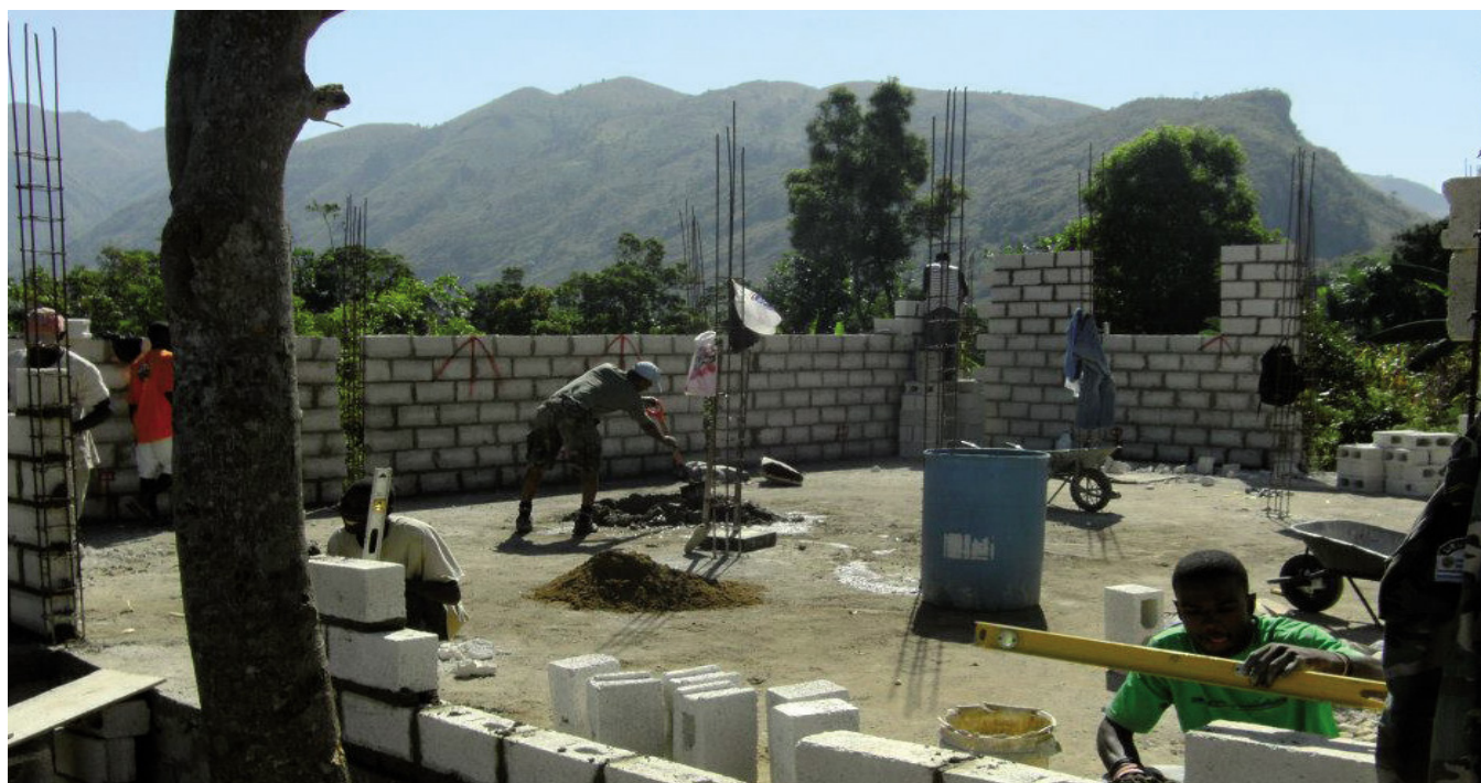
Personal del Batallón “Uruguay VI” construyendo conjuntamente con voluntarios efectivos del contingente hindú y la comunidad local.
