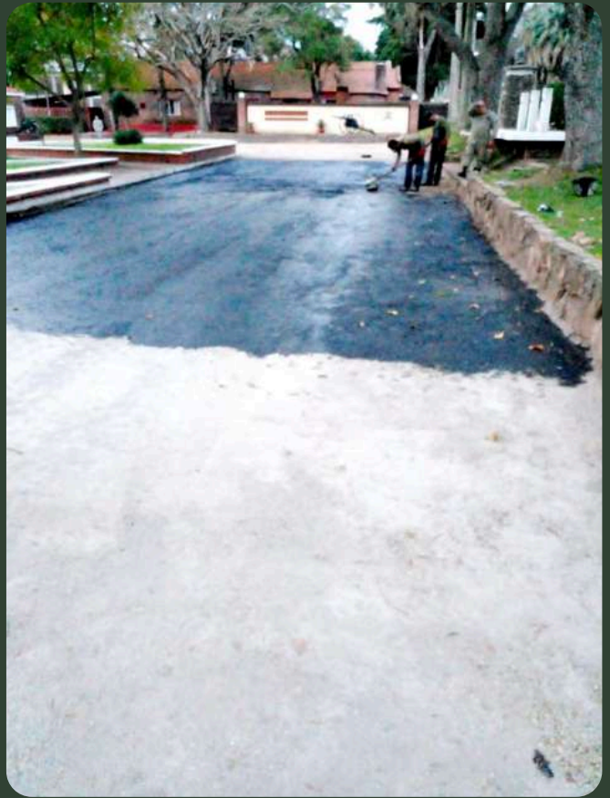
Fotografía durante los trabajos (imprimación asfáltica).
