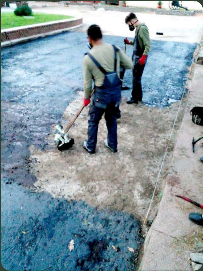
Fotografía durante los trabajos (imprimación asfáltica).
