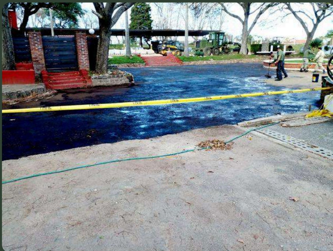
Fotografía durante los trabajos (imprimación asfáltica).
