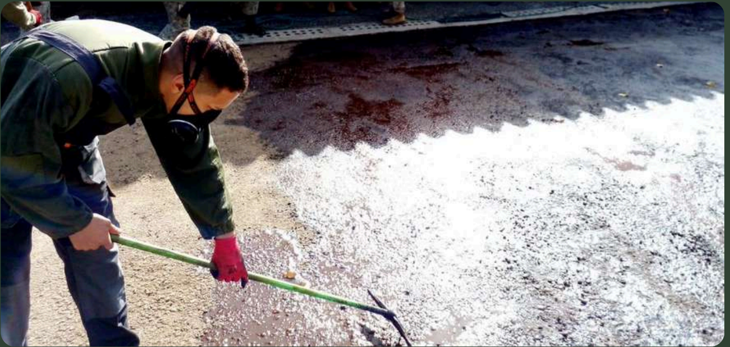
Fotografía durante los trabajos (imprimación asfáltica).
