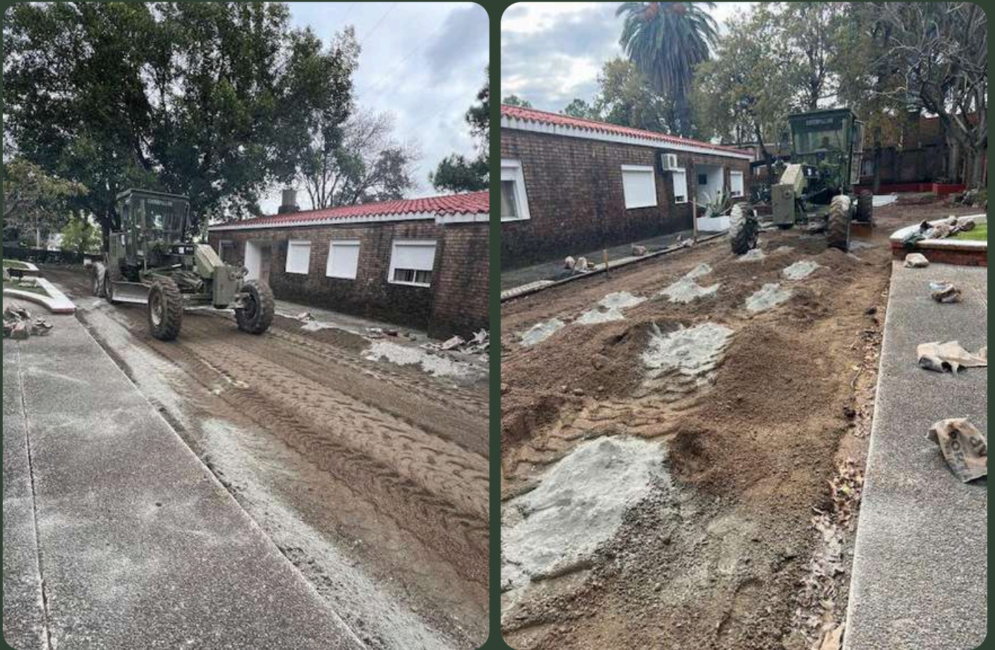
Fotografía durante los trabajos (cementación).
